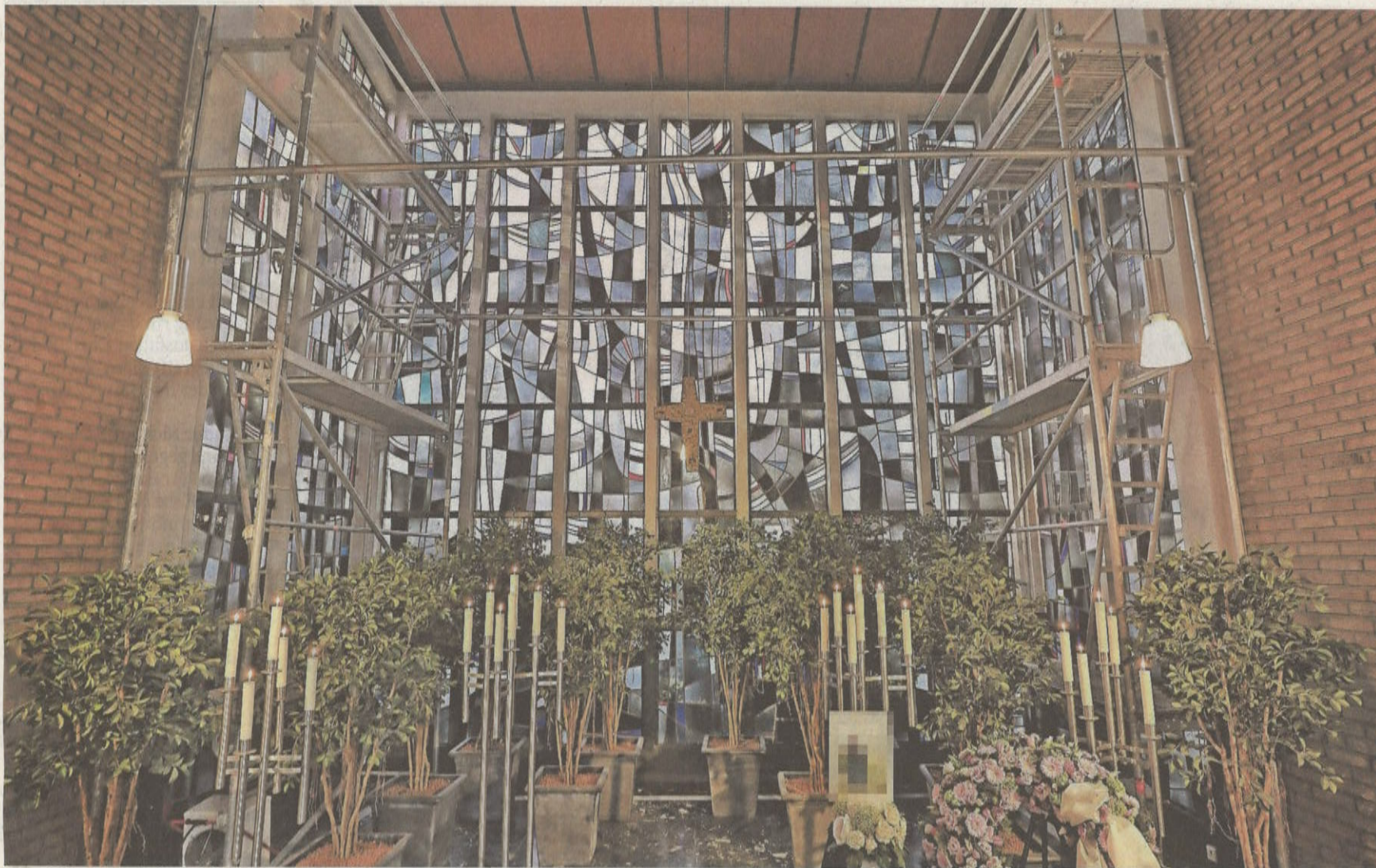
In der Hülser Trauerhalle sind die Gerüste aufgestellt: Vom Boden bis zur Decke müssen die Fenster saniert werden.
